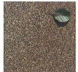
Cortenstahl ist das vorherrschende Material im Park. Der Belag besteht aus wasserdurchlässigem, epoxidharz-gebundenem Splitt.
