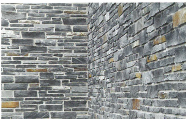
Fruchtschiefer in einer weiteren Facette: Im Bereich der Wasserfälle wurde eine Wand mit dem Naturstein gestaltet
