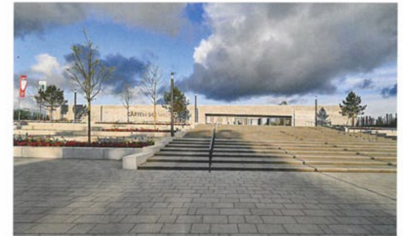
Großzügiger Vorplatz mit Treppenanlage an der Westseite des neuen Gebäudes.
