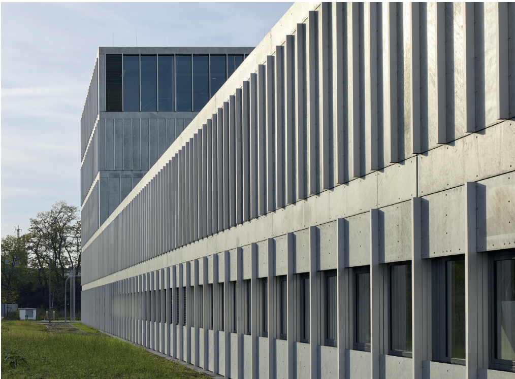
1. Preis GEPLANT+AUSGEFÜHRT 2020 · Feuerwehrzentrum Köln-Kalk
