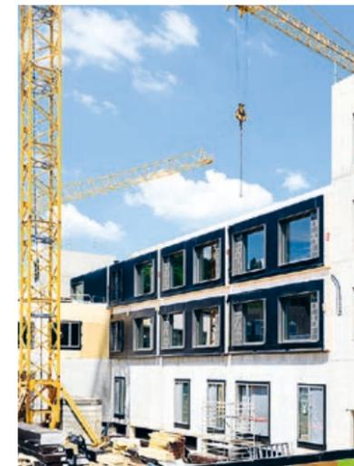
Das Sockelgeschoss und die Treppenhäuser sind mit Beton ausgebildet, die darüberliegenden Ebenen werden als in großen Teilen vorgefertigter Massivholzbau aufgesetzt. The plinth level and the staircases are made of concrete, while the levels above are largely executed in prefabricated solid wood construction.
